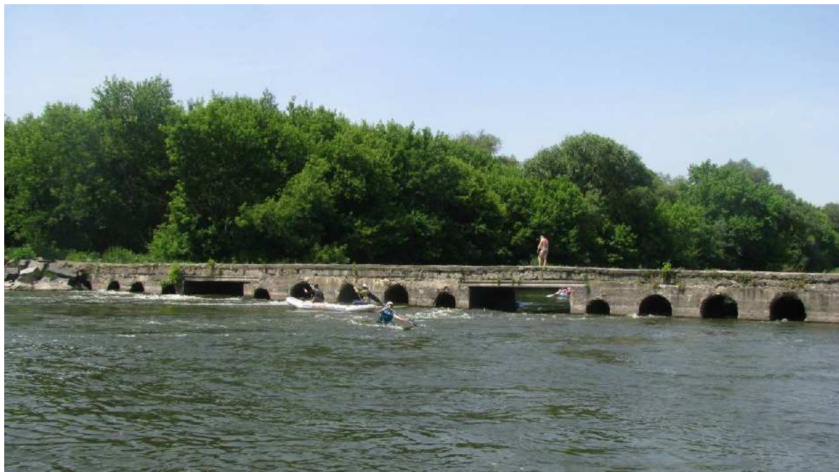
Фото 22– Бетонный мост в с. Харитоновка
