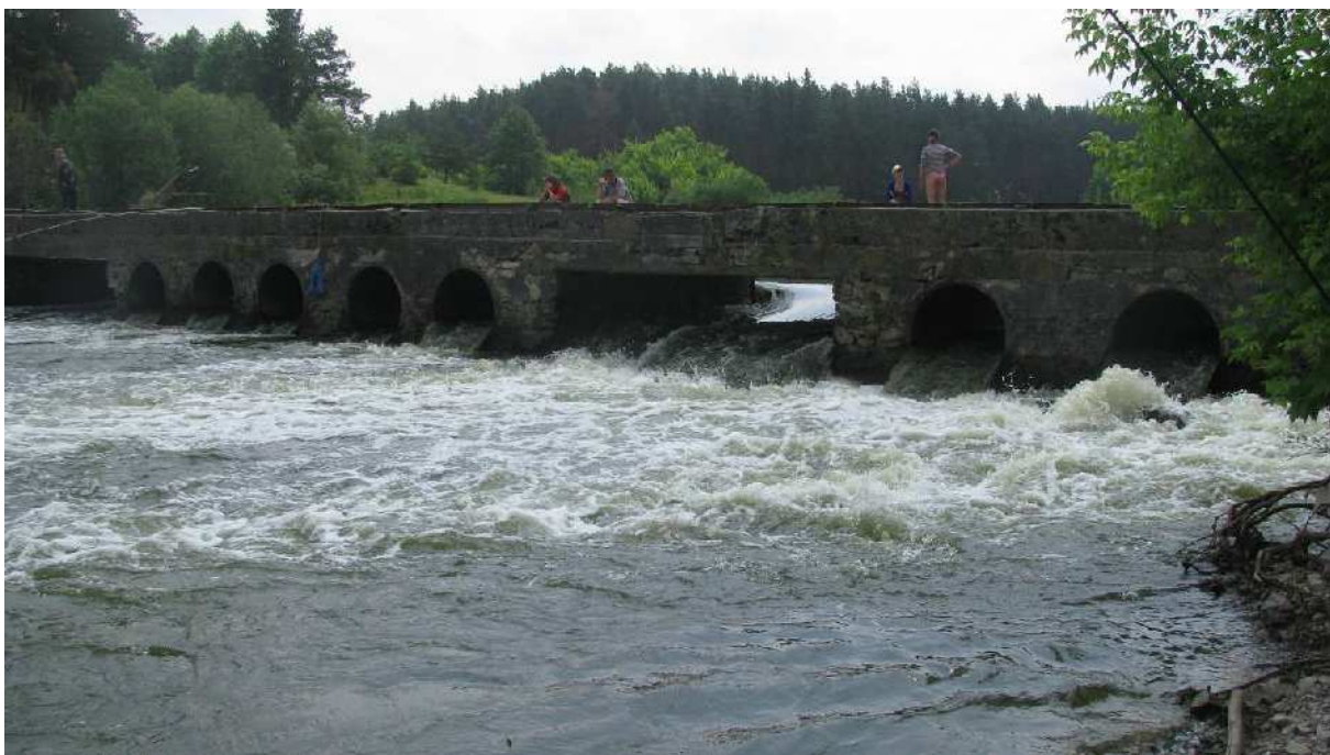
Фото 31 – Бетонный мост в с. Городское
