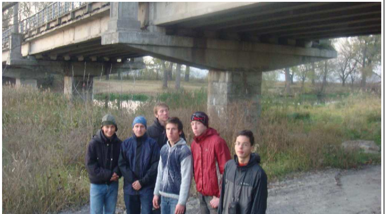
Фото 24. КП-14, автомобільний міст траси Гнатівна - Білогородка
