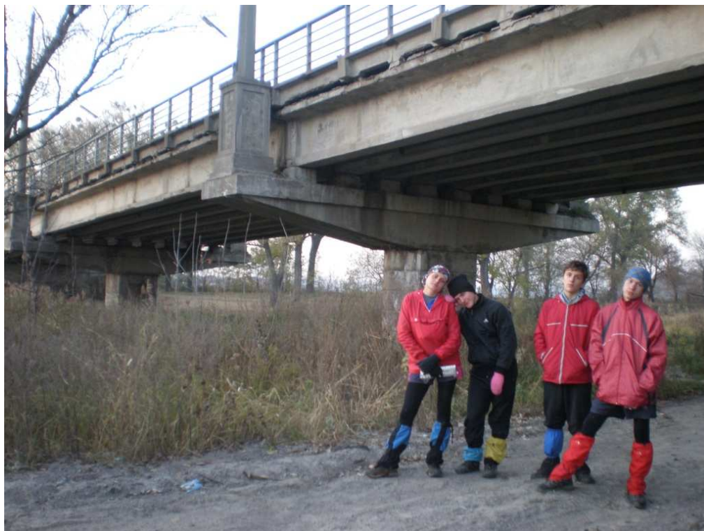
Фото 38 - Железобетонный мост через р. Ирпень (трасса Р30 Киев - Житомир) - КП№14
