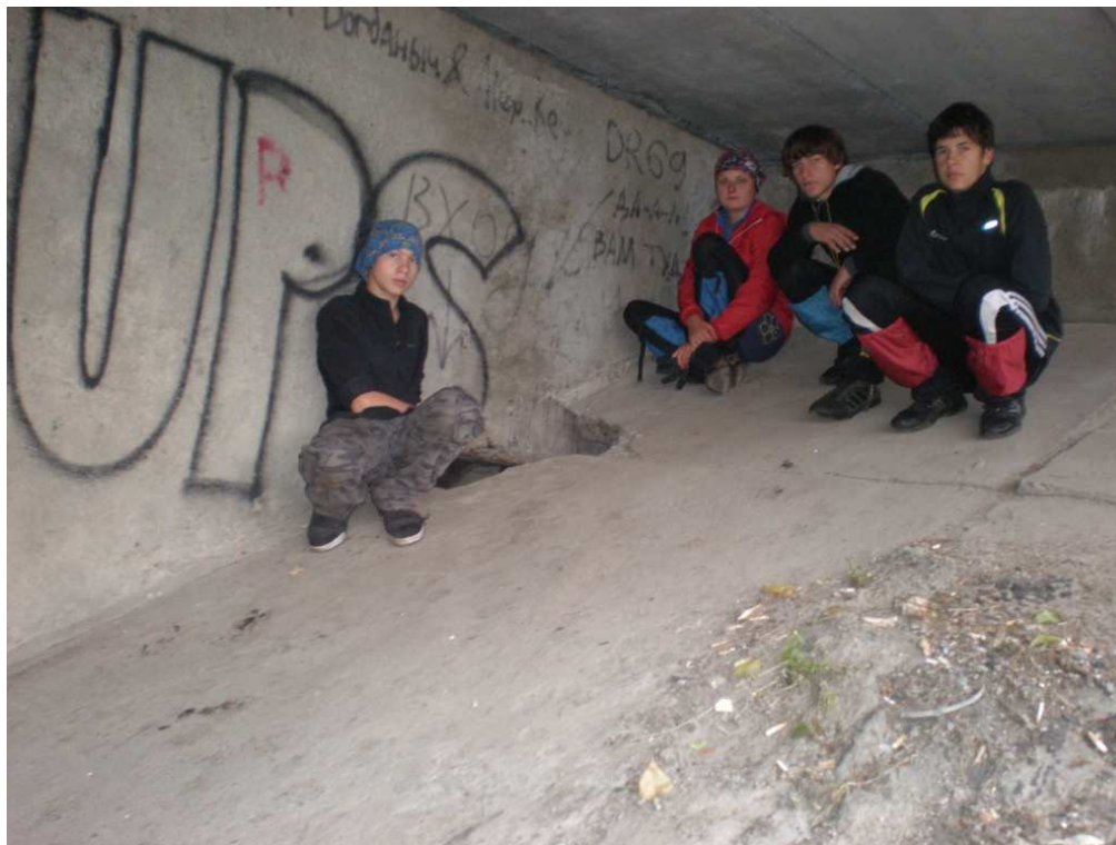
Фото 45 - Автомобильный мост через р. Ирпень. ДОТ №410 - КП №17
