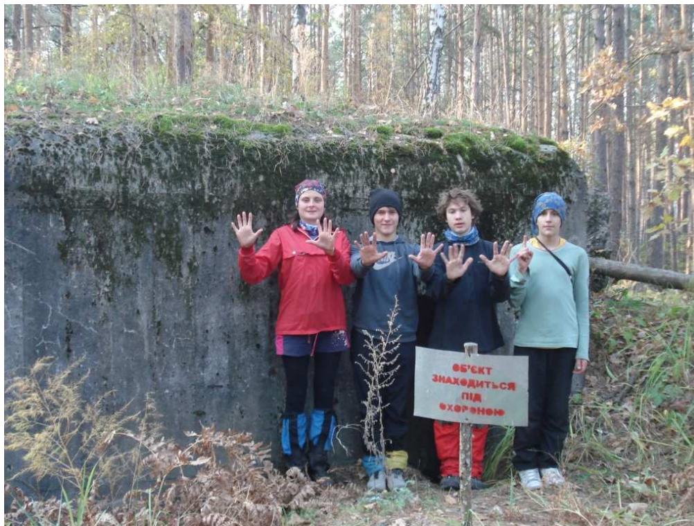
Фото 71 - ДОТ №508 – КП№31. ДОТ трехамбразурный, полуразрушенный, по конструкции похож на 506.
